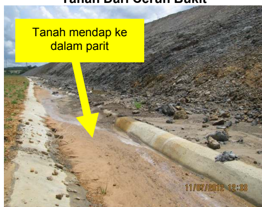
Gambar 2.1 Parit Tersumbat Dengan Hakisan Tanah Dari Cerun Bukit
