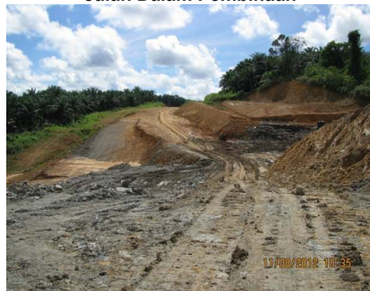
Gambar 2.6 Jalan Dalam Pembinaan
