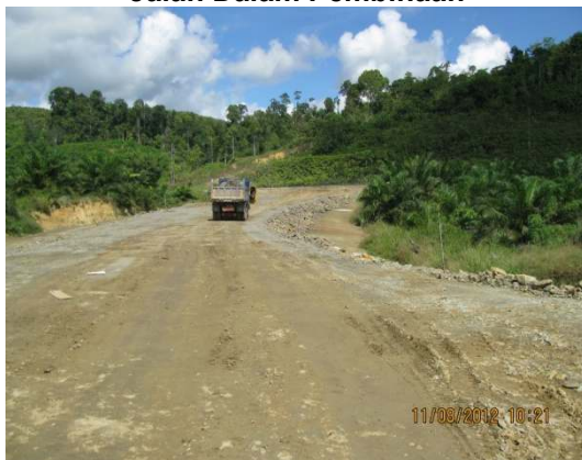
Gambar 2.5 Jalan Dalam Pembinaan
