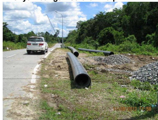
Gambar 2.19 Penyambungan Saluran Paip Air HDPE
