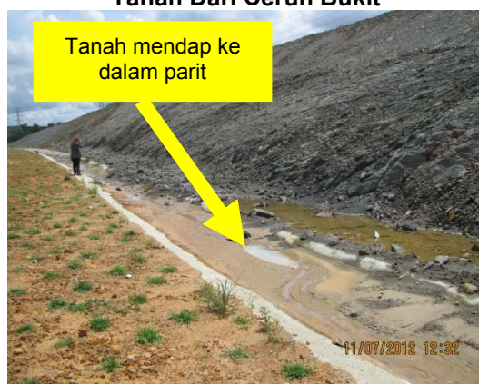
Gambar 2.2 Parit Tersumbat Dengan Hakisan Tanah Dari Cerun Bukit
