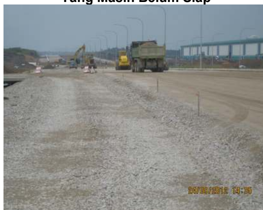
Gambar 2.4 Pembinaan Jalan Seksyen A Yang Masih Belum Siap
