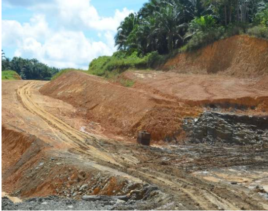
Gambar 2.7 Pembinaan Slope Protection
