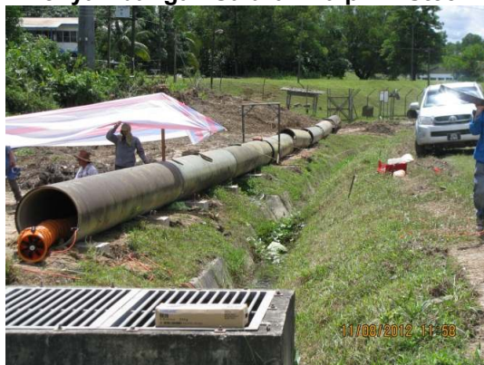
Gambar 2.18 Penyambungan Saluran Paip Air Steel
