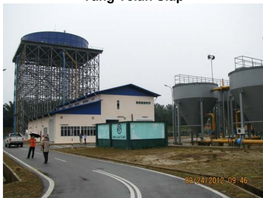
Gambar 2.16 Loji Rawatan Air Berkapasiti 5 MLD Yang Telah Siap
