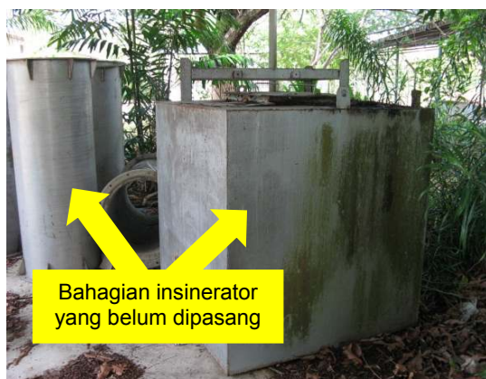
Gambar 3.33 Bahagian Insinerator Yang Belum Dipasang
