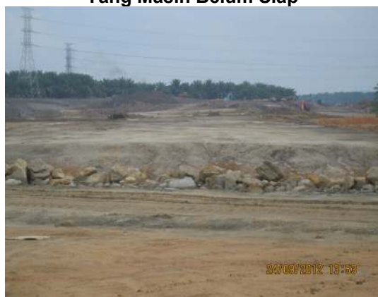
Gambar 2.3 Pembinaan Jalan Seksyen A Yang Masih Belum Siap
