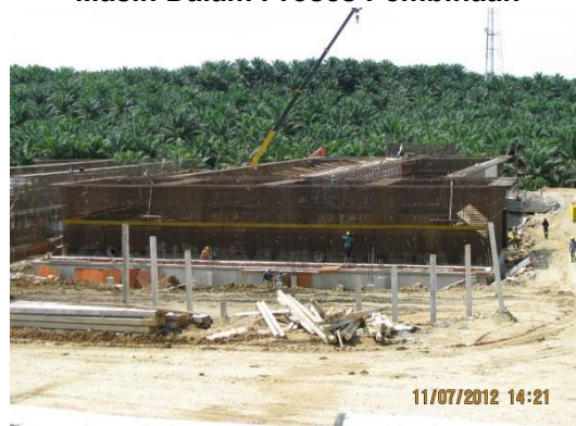
Gambar 2.17 Loji Rawatan Air Berkapasiti 80 MLD Masih Dalam Proses Pembinaan
